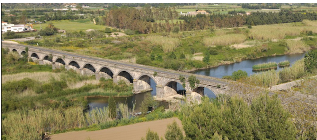
Figura 8: Vista attuale del ponte e dell'alveo del fiume Cedrino a Orosei
