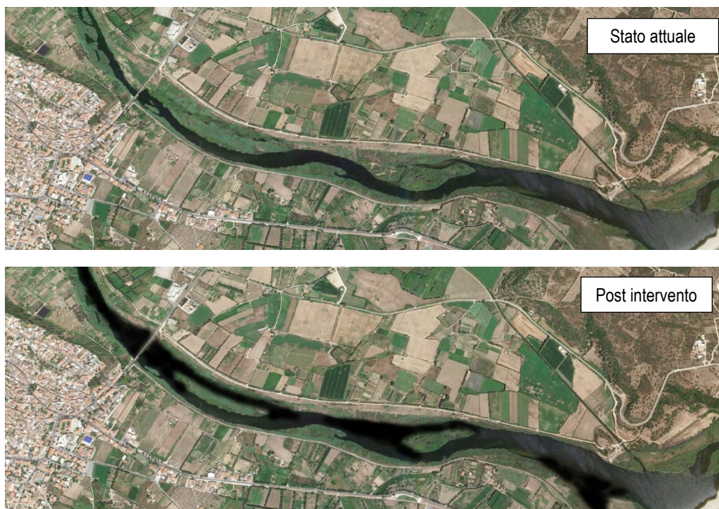
Figura 12: Interventi di escavo in alveo
