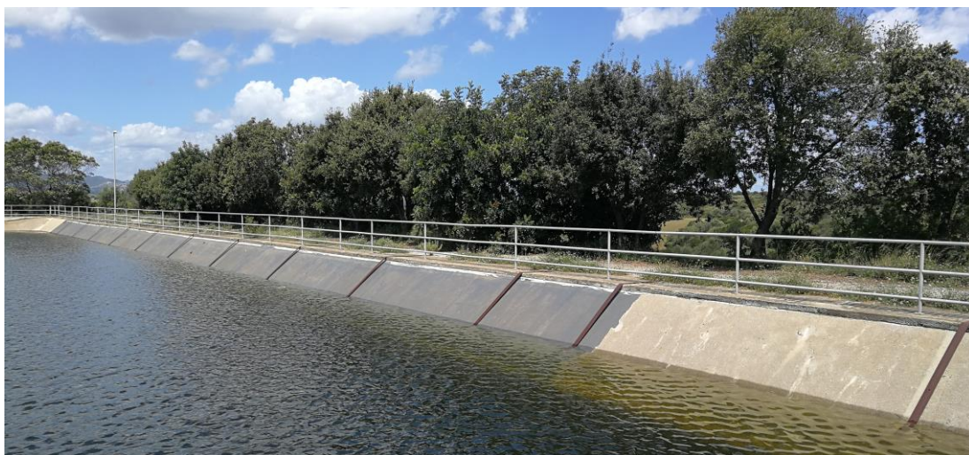
Figura 6 – Vasca di Capo Comino – Vista lato D
